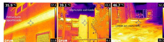
Fig. 5. Termografías de superficies de fachadas y entorno: Estructura aporticada (izquierda), concreto estriado (centro), pisos con losas de concreto (derecha).
