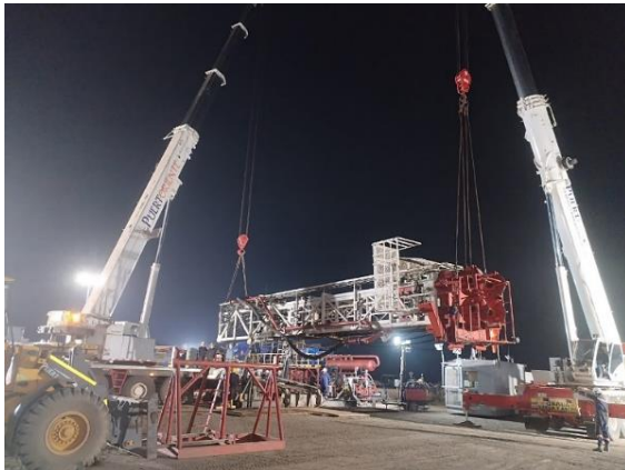
Fig. 6. Izaje de mástil mediante grúas telescópicas, procedimiento usado para tomar valor de peso del mástil del NOV rapid Rig 13.
