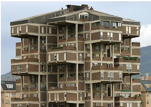
Figura 1. Arquitectura de los 70s (Fuente: Blancko style, 2023).
