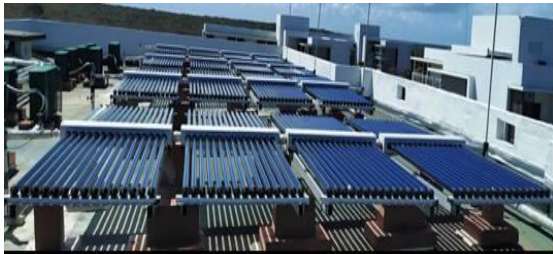
Figura 1. Calentadores solares en Pilar 2.
