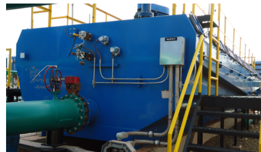
Fig. 4. Vista de perfil de la celda de flotación.
