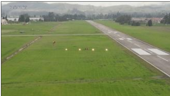
Fig. 1. Configuración de luces P.A.P.I. Fuente: Imagen propia
