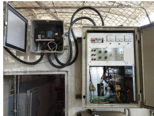
Fig. 10. UMR Implementada sobre rectificador de protección catódica
