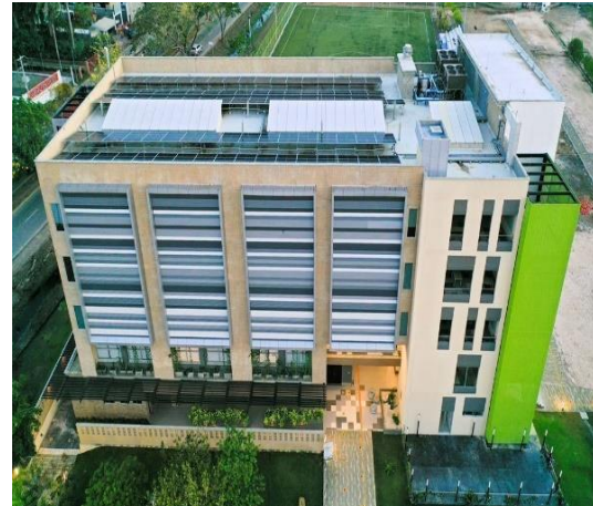
Fig. 1. Planta solar fotovoltaica ubicada en la azotea del edificio.
