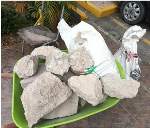
Figura. 1. Recolección de residuos de construcción y demolición.
