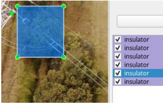
Fig. 7. Etiquetado de aisladores eléctricos en líneas de transmisión eléctrica usando el software Label-Img. Fuente: Autores
