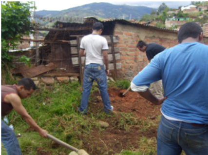
Fig. 10. Adecuación del terreno para la instalación de los juegos infantiles
