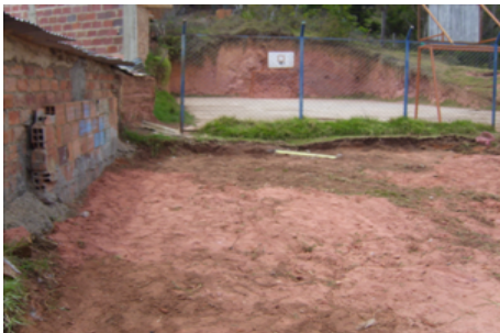
Fig. 11. Adecuación del terreno para la instalación de los juegos infantiles
