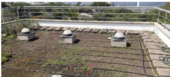
(a) Colocación de la red de riego.
