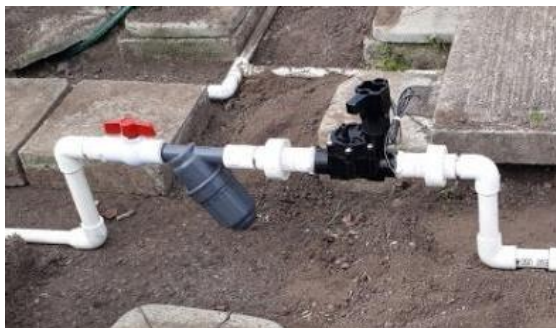
(b) Válvula de bola de tubo de agua, filtro de agua y electroválvula de agua.
