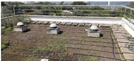
(a) Colocación de la red de riego.
