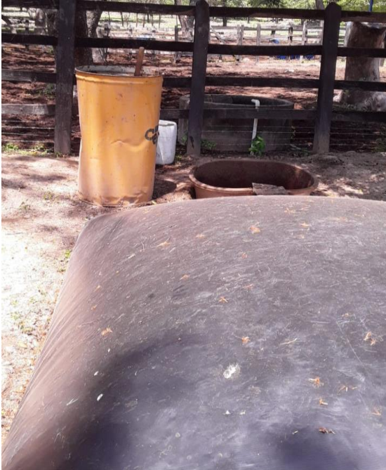
Figura 5. Tanque amarillo para la mezcla de las excretas antes de verterlo en el biodigestor
