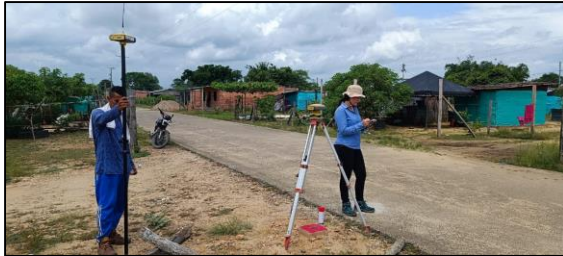
Figure 2. Mojoneros en concreto para ajuste de la topografía.
