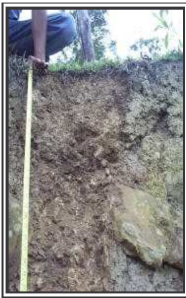
Figura 5: Perfil de suelo compuesto por arcillolitas, materia orgánica, presencia de areniscas consolidadas en matriz 40%, se localiza a 250 m margen derecho de la quebrada Ulagá.
